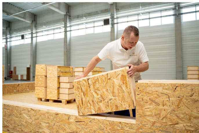
Proces montażu domu testowego
