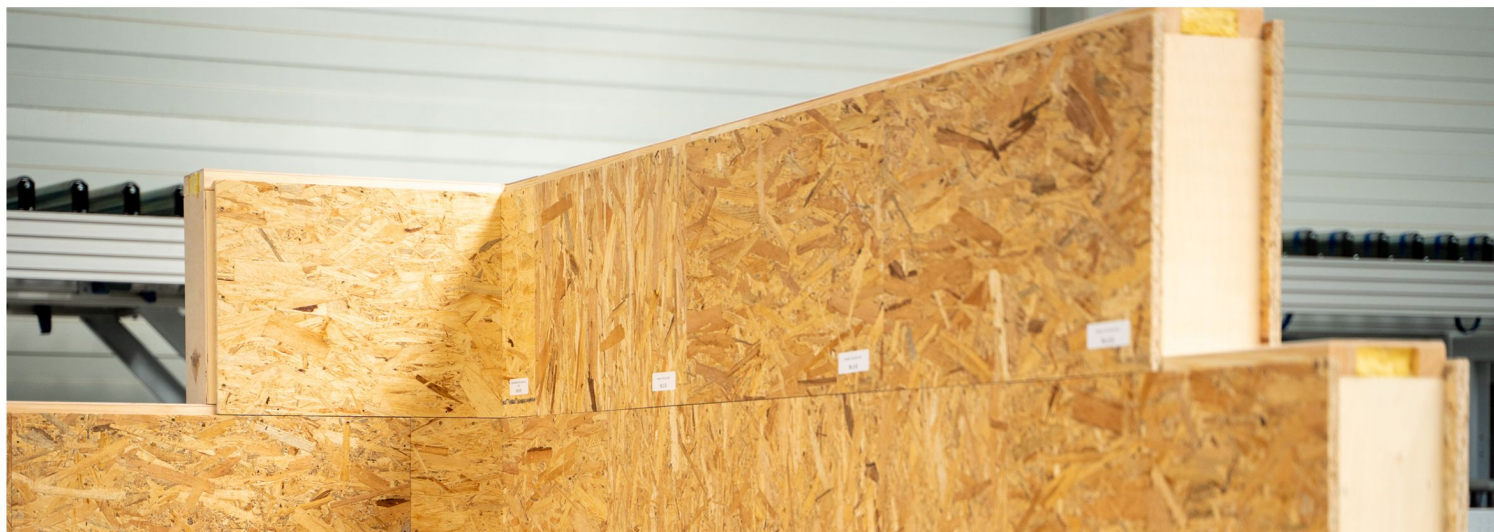
Częściowo zbudowana ściana zewnętrzna
